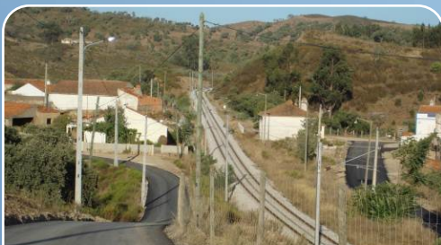
PEREIRAS-GARE - PAVIMENTAÇÃO ARRUAMENTOS NORTE DA LINHA FERREA
