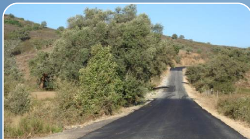
CM1190 - REPOSIÇÃO DE PAVIMENTOS/REPARAÇÃO
